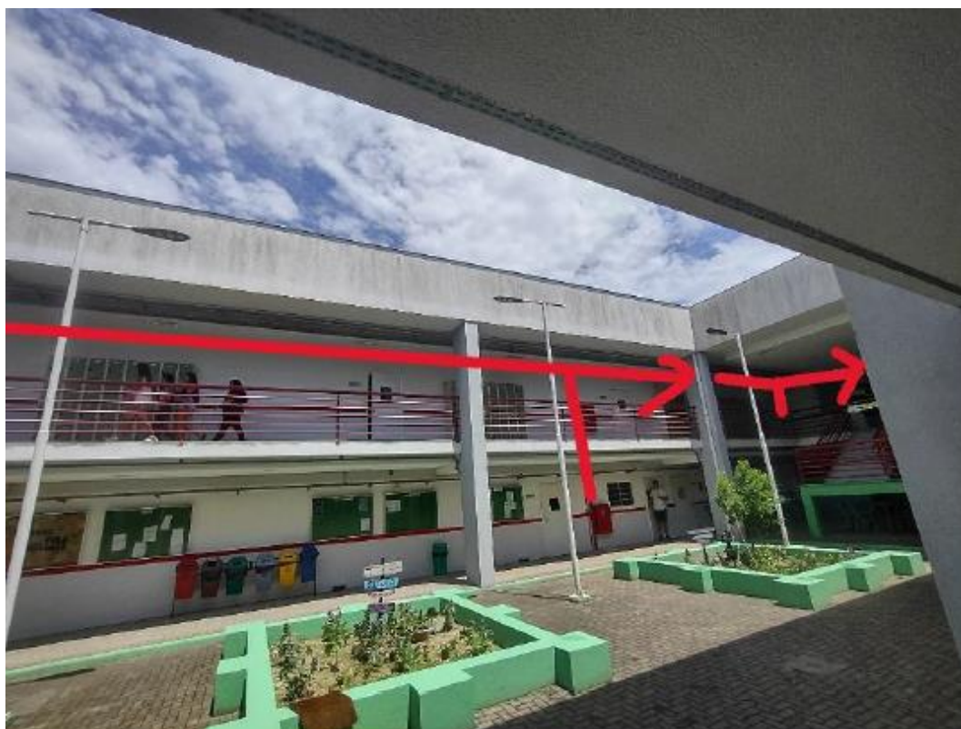
A tubulação segue pela circulação do bloco maior. Deve haver tê com prumada alimentando o hidrante do térreo que aparece na foto.
