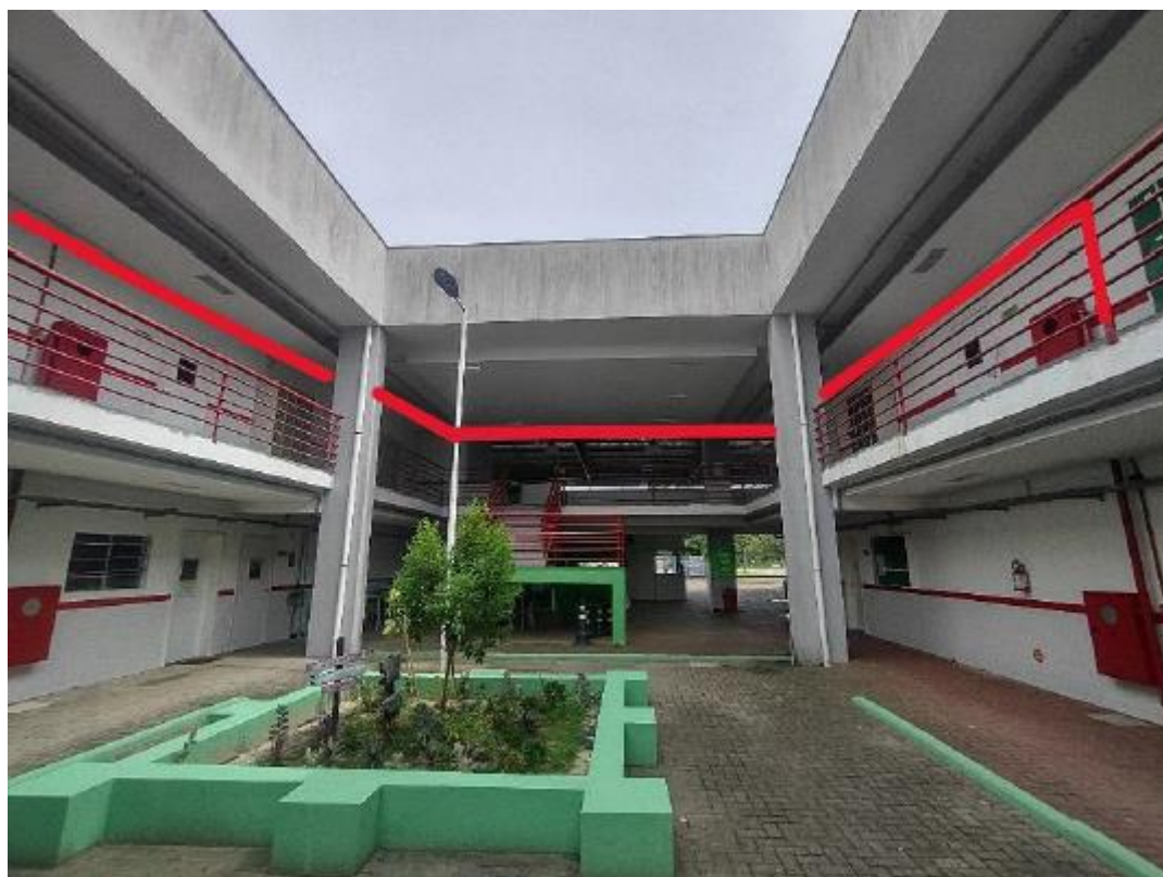
A tubulação cruza a circulação superior para alimentar hidrantes na circulação oposta (térreo e superior, à direita na foto), bem como um novo hidrante próximo ao auditório e hidrante existente na porta da biblioteca (ambos exibidos na próxima foto).
