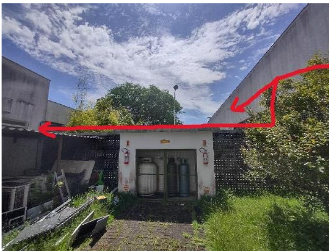
Voltando à tubulação após o abrigo: um ramal segue sobre o muro da central de gás, em direção ao refeitório.
