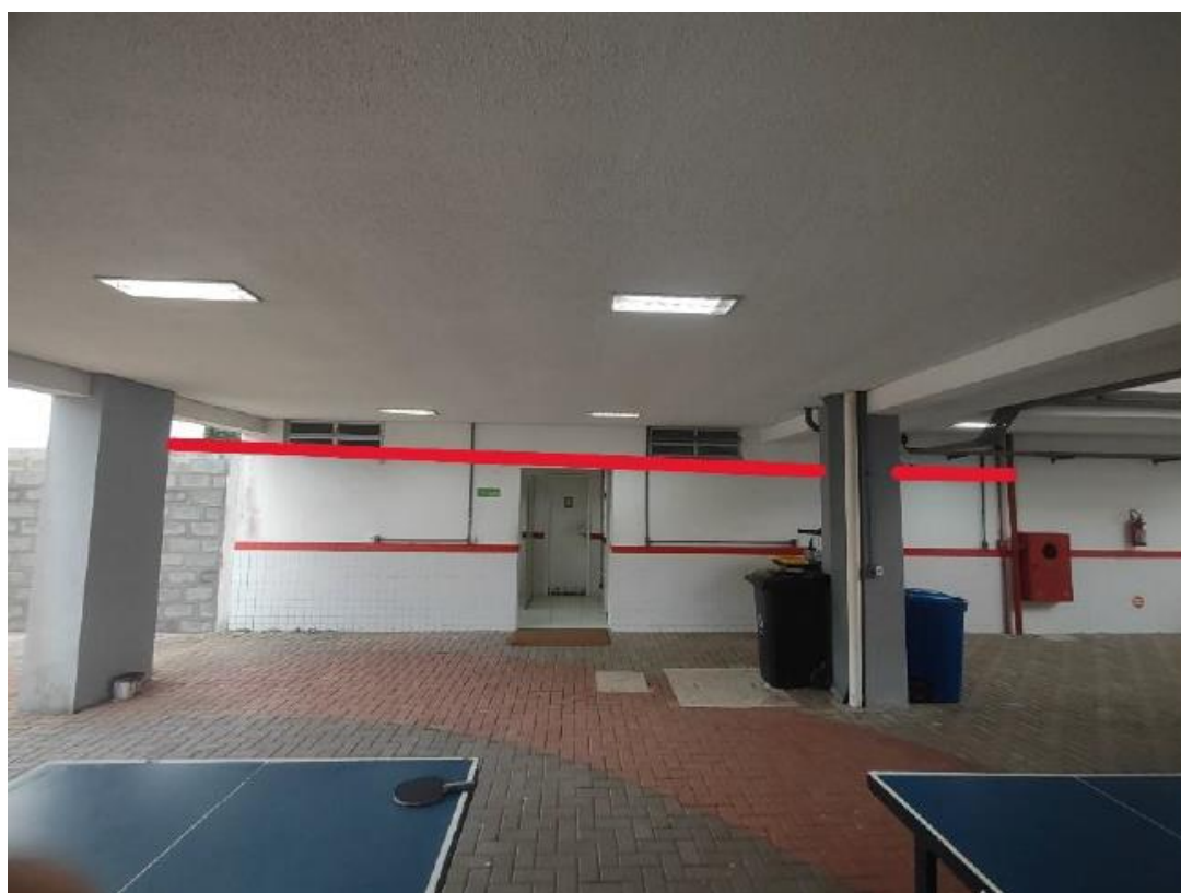
A tubulação segue pela circulação térrea e se conecta à prumada existente. Ali, alimenta hidrante existente e “sobe” ao pavimento superior. Não existirá mais o trecho que seguia enterrado (abaixo do hidrante).
